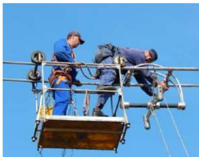
Рис.8. Установка гасителя пляски TDD2.3 на ВЛ 400 кВ Исакча-Тульча в Румынии.
