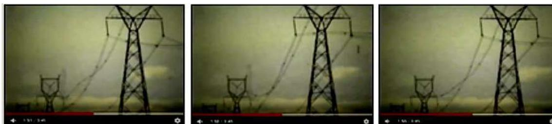
Рис.2. Три кадра видеосъемки процесса пляски проводов воздушной ЛЭП с расщепленными фазами (сняты с интервалом через примерно 1,5 сек каждый).
