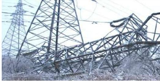
Пр.3.6. Разрушенная мощным ледяным штормом с пляской опоры ЛЭП, Канада, 1998 год. (В центре – поврежденный пляской гаситель вибрации).
